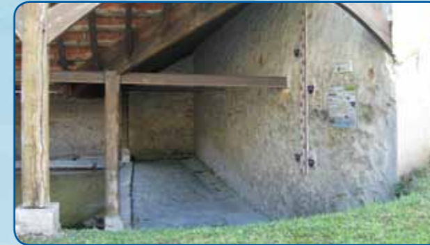
Repère de crue à Jouy-le-Moutier, posé en 2012
