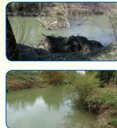
Enlèvement d'encombres avant/après
