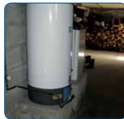
Travaux de réduction de la vulnérabilité (rehausse d'une chaudière)
