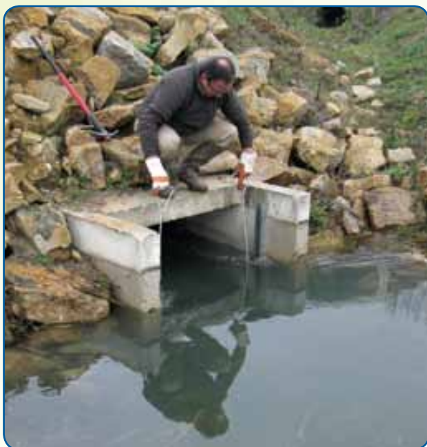
Manipulation de batardeaux sur le site de Longueil-Sainte-Marie
