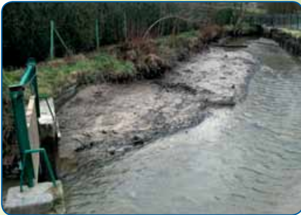
Restauration du ruisseau de Wimpy avant travaux (janvier 2009)
