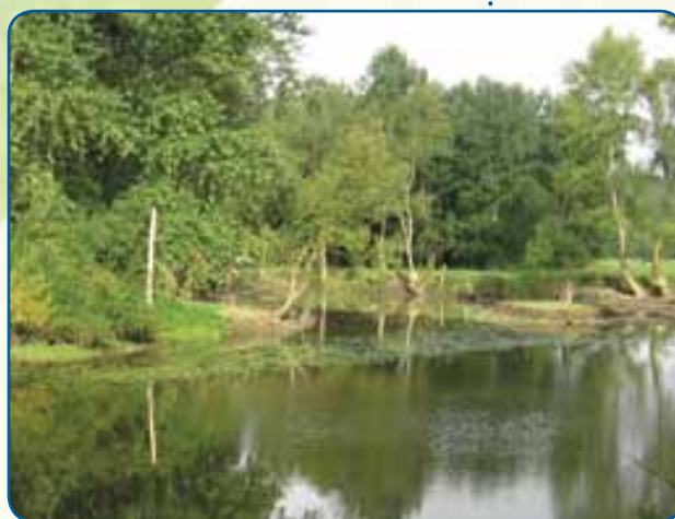
Une opération de reconnexion d'une annexe hydraulique sur le DNN
