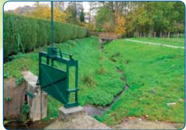
Restauration du ruisseau de Wimpy après travaux (novembre 2011)
