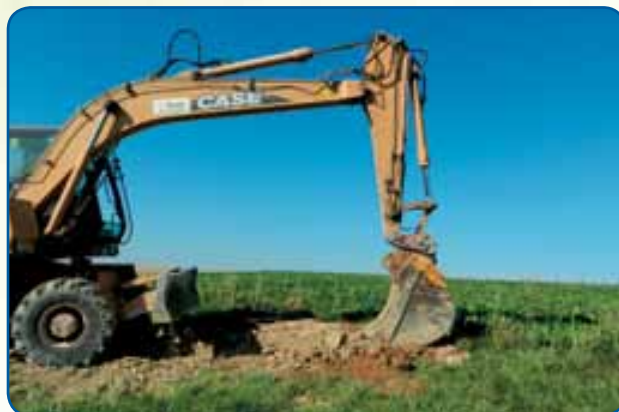
Sondages géotechniques sur les parcelles agricoles
