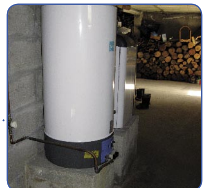
Travaux de réduction de la vulnérabilité (rehausse d'une chaudière)
