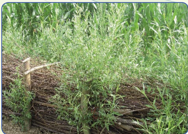
Travaux de la mission érosion de l'Aisne
