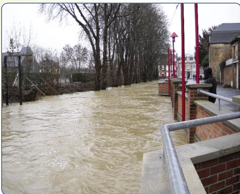
Exemple de protections rapprochées en centre urbain (Mairie de Guise)
