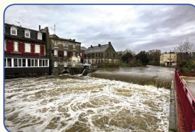
Seuil pasteur à Hirson (02) lors de la crue de novembre
