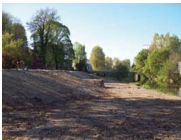
Travaux de l'Union des syndicats de rivières de l'Aisne
