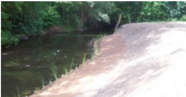
Aménagements de berges - (Union des syndicats de rivières de l'Aisne)
