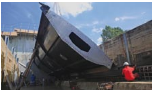
Opération de pose du clapet de régulation
