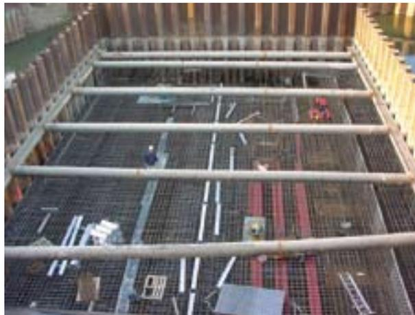
Travaux de ferrailage de l'ouvrage central
