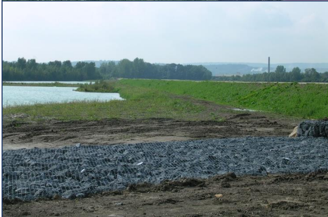
Casier avec un déversoir au premier plan et une digue à droite, Entente Oise-Aisne, 2006
