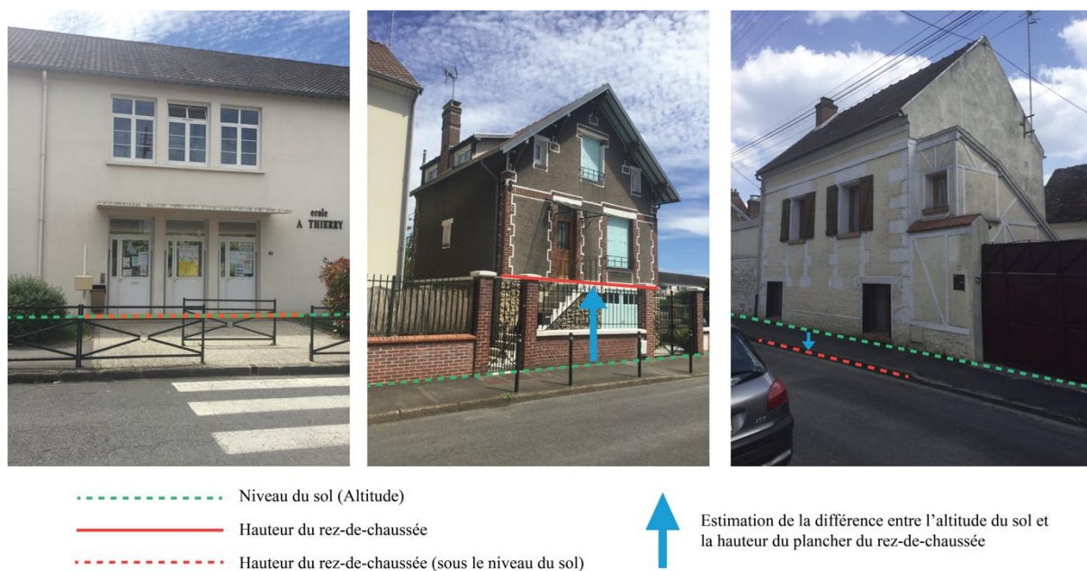
Figure 7 : Méthode pour estimer la hauteur du RDC (photographies prises par Pierre Brétaudeau, 2017)
