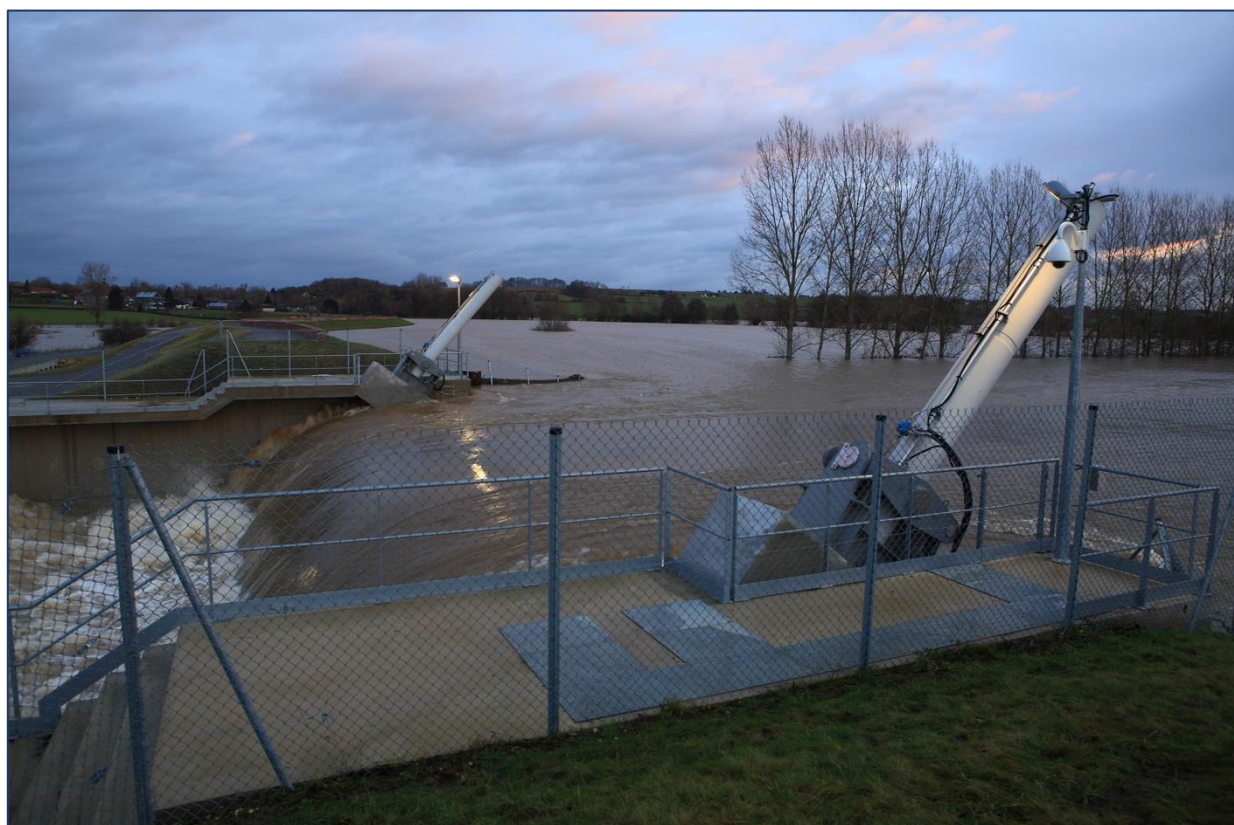
L'aménagement de Proisy (clapet au premier plan, digue à gauche et zone de rétention à droite) pendant la crue de l'Oise de janvier 2011, Entente Oise-Aisne, janvier 2011
