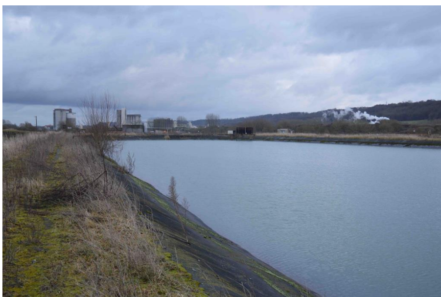
Ancien bassin de sucrerie à Vic-sur-Aisne, sélectionné pour devenir un bassin de stockage des eaux de l'Aisne en cas de crue (Entente Oise-Aisne, 2013)
