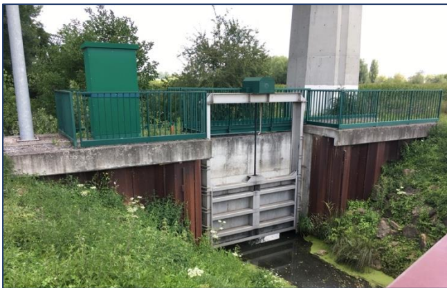
Vanne (V5) pendant un test de fermeture, Pierre Brétaudeau, juillet 2017
