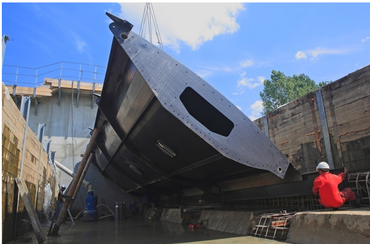
Installation du demi-clapet de Proisy (O2).
