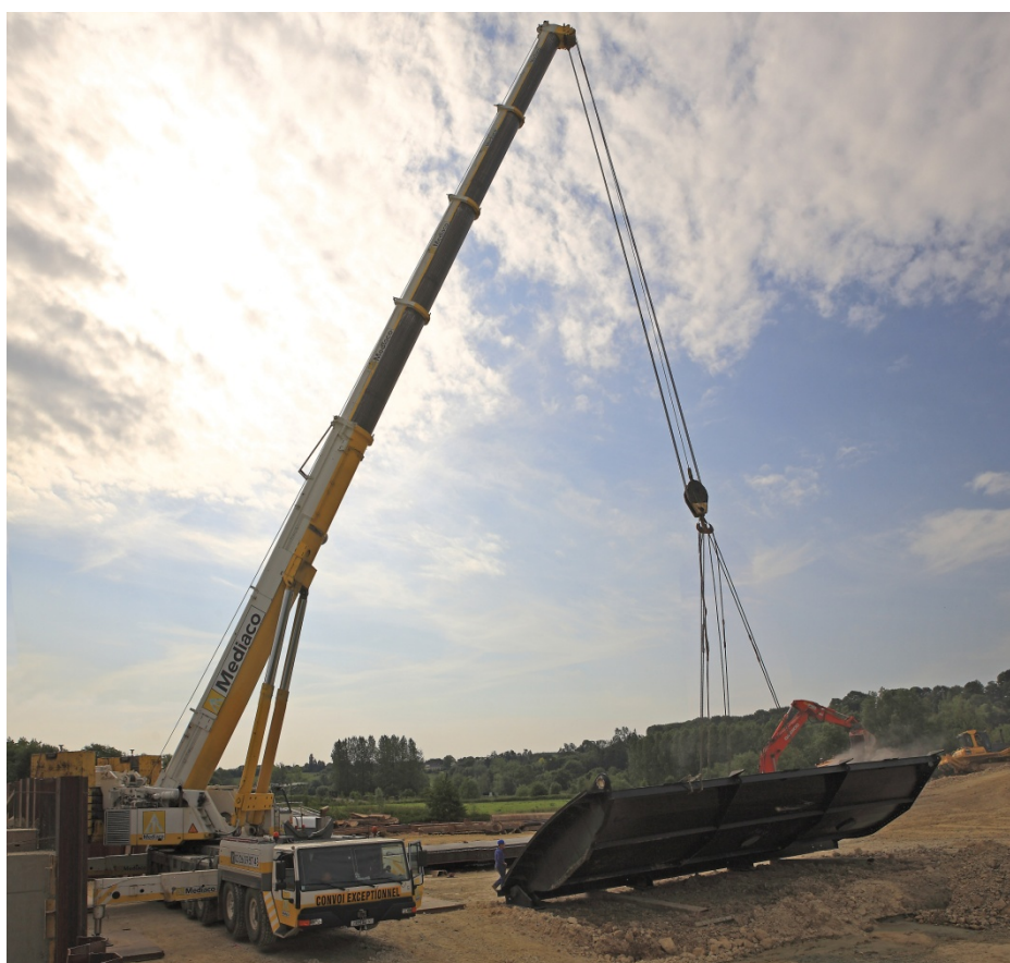
Pose du clapet de Proisy (O2).
