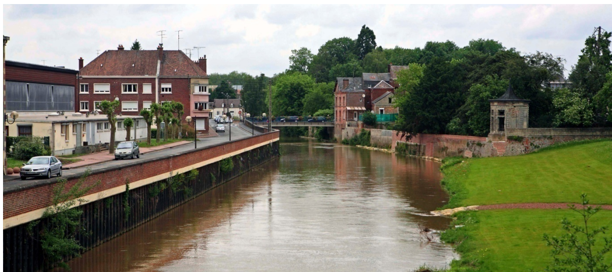
Protections dans la traversée de Guise (02), à la cote décennale contrôlée par l'aménagement de Proisy localisé 15 km en amont. A gauche, des murets étanche, à droite un merlon de terre.
