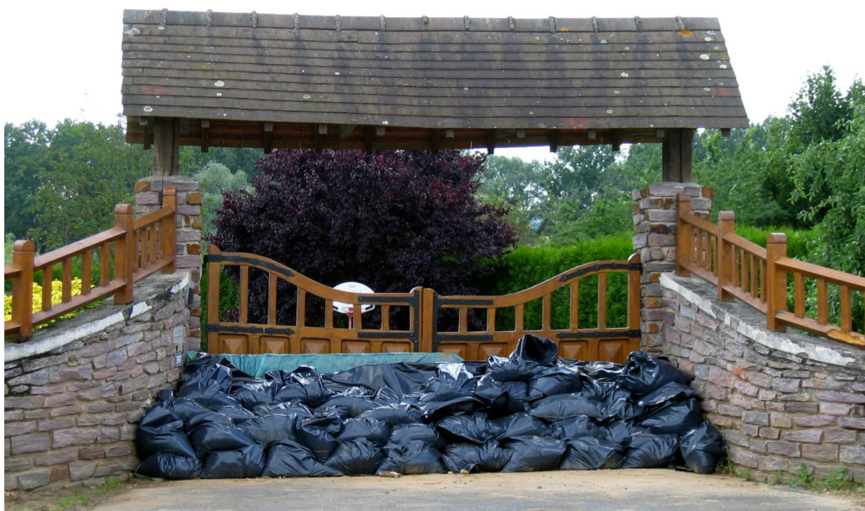
Protection de fortune lors de la crue de la Verse de juin 2007, à Noyon.
