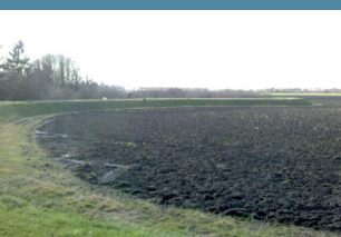
Exemple de réalisation de protections rapprochées aménagées entre Pont-Sainte-Maxence et Verberie
