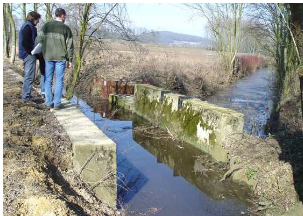
Photo N°9 : Croisement du Ru Gaillant avec fossé transversal
