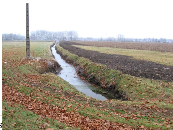
Photo N°10 Fossé des aiguillons au lieu dit « Terres fortes » commune de Rhuis
