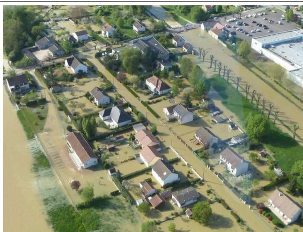
Tonnerre – Inondation entre l'Armançon et le canal de Bourgogne (rue de la Bonneterie) (Source : SPC SMYL)
