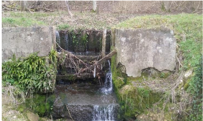
Figure 10 : Déversoir sur la digue de la Nonette
