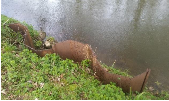
Figure 9 : Palplanches sur la Nonette
