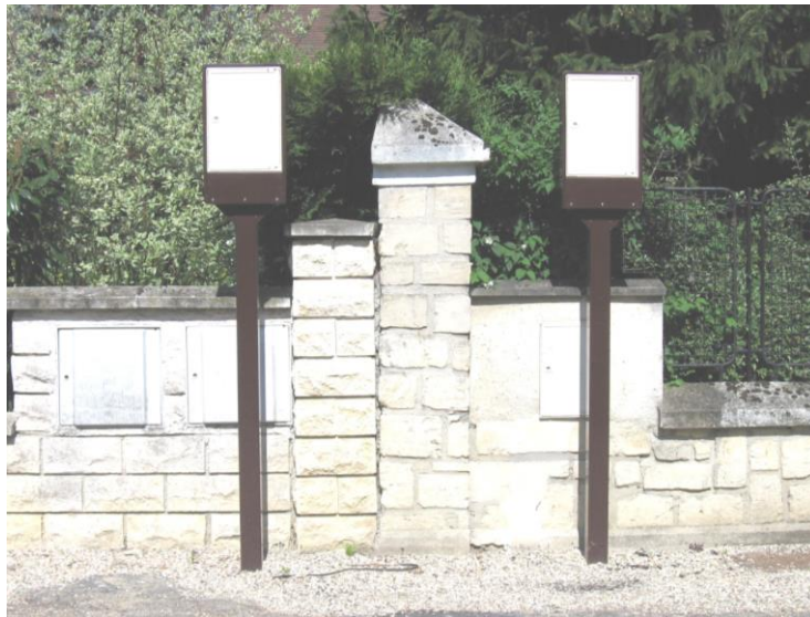
Photographie 12 - Rehausse des compteurs électriques à Jouy-le-Moutier (95)
