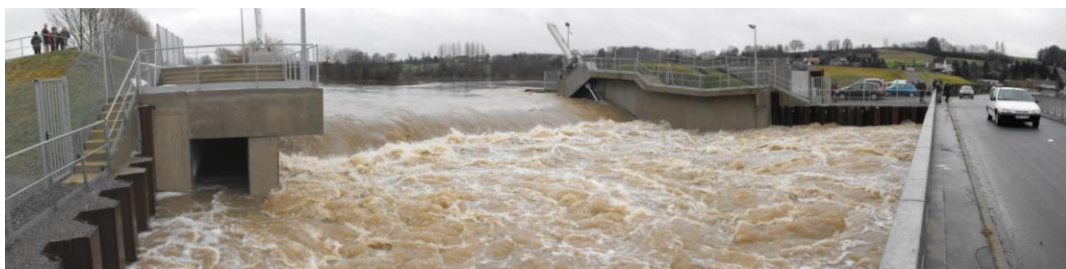
Photographie 8 - Régulation de la crue de janvier 2011 à Proisy (EOA, 2011)
