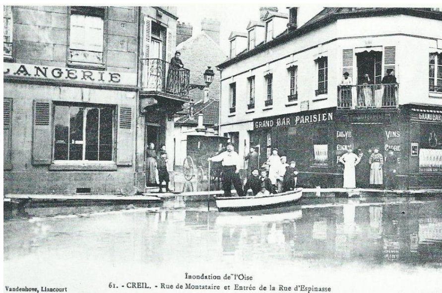
Photographie 5 - Inondations de 1910 à Creil : rue de Montataire et entrée de la rue d'Espinasse
