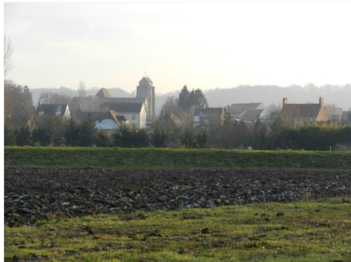
Photographie 16 - Digue de Verberie (60)
