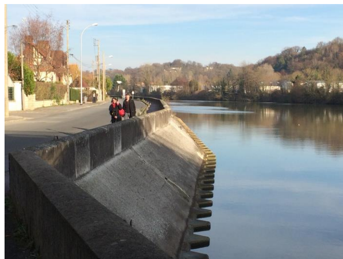
Photographie 17 - Les murets de protection de Creil (60)
