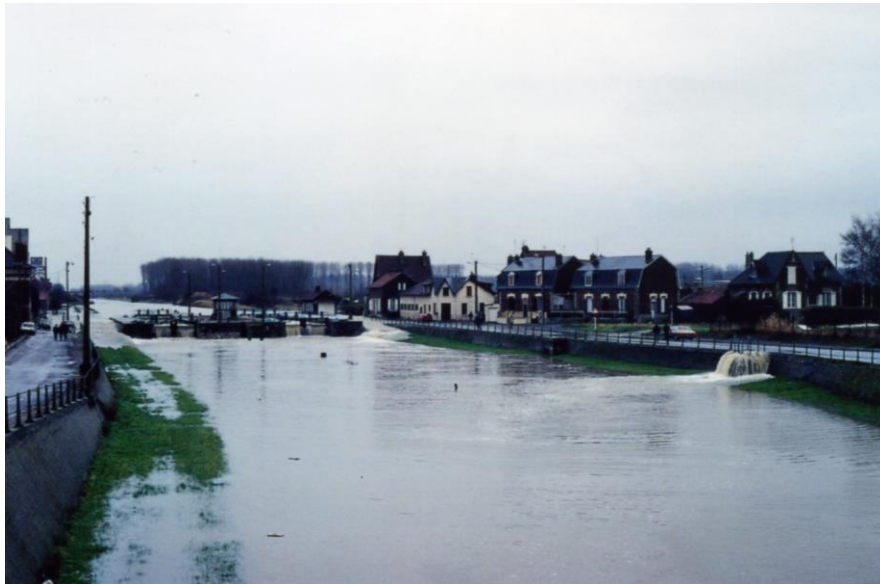
Photographie 11 - L'Oise se déversant dans le canal de Saint-Quentin à Chauny (02) (André Dague, 1993)
