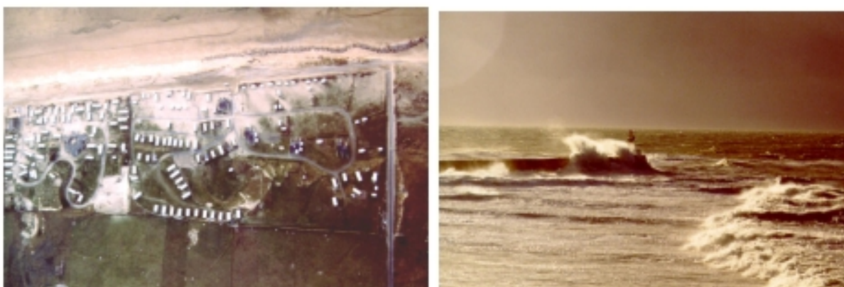
Figure 66 : Côtiers Normands Tempêtes et submersions de février 1990 : le littoral nord de Gouville-sur-Mer : recul du trait de côte malgré la présence de sacs en géotextile protégeant le haut estran / vagues de tempête à Barneville-Carteret (Sources : CG Manche)
