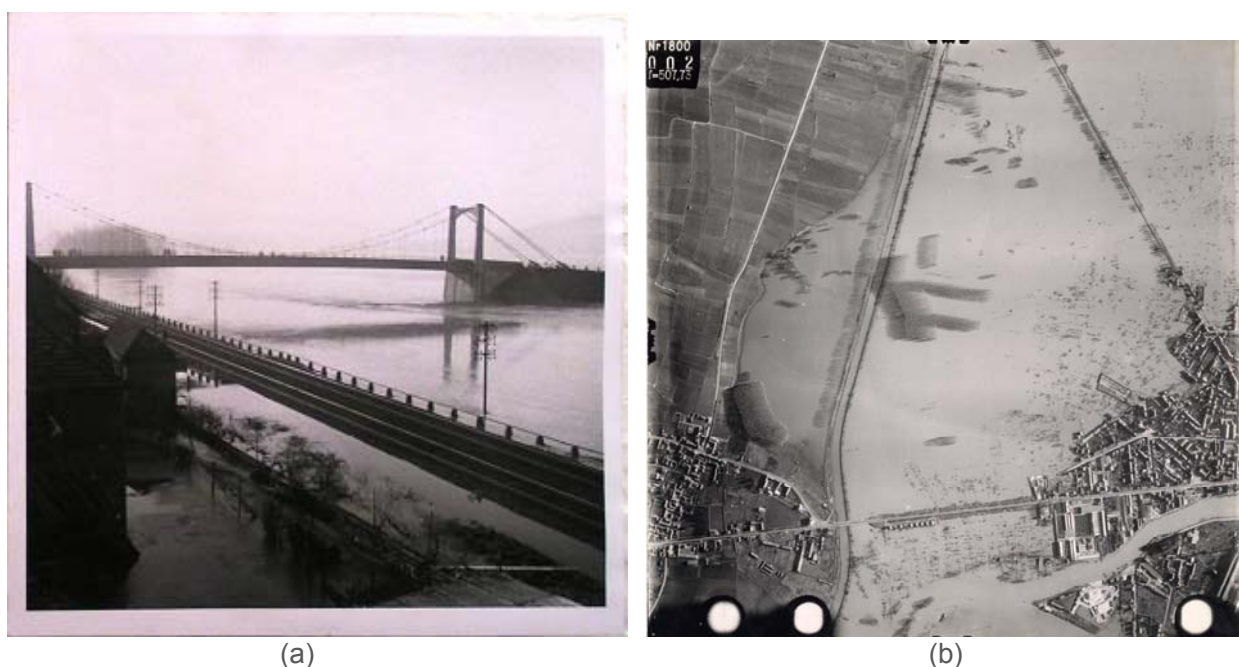
Figure 133 : Vallées de Marne - : Crue de la Marne en janvier 1955 – (a) Pont de Dormans et abords ; (b) Vue aérienne au droit de la commune de Magenta (source : SPC SAMA)
