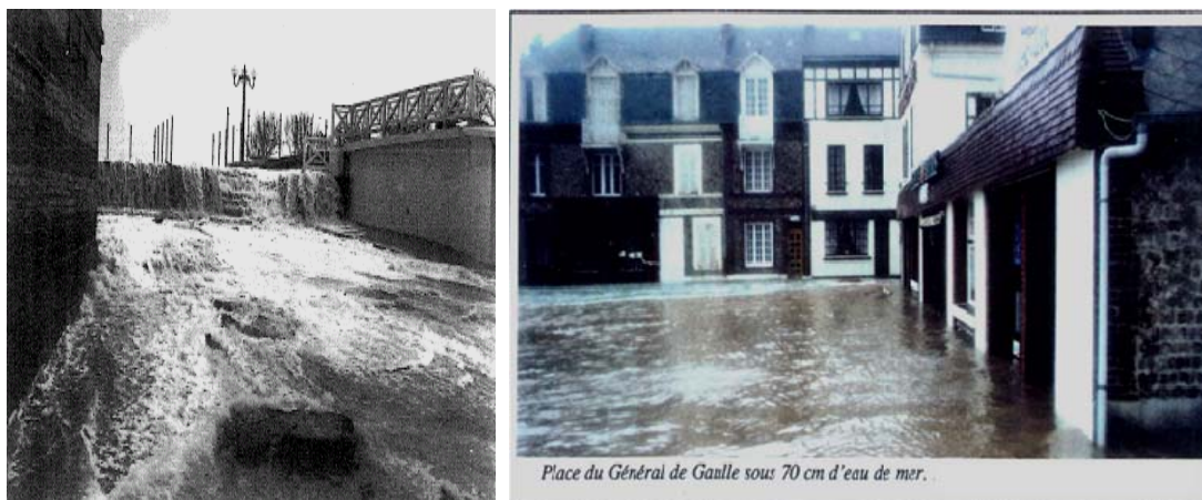
Figure 99 : Seine Aval - Etretat, tempête des 27-28 février 1990 (Source L'Estretatais N° Mars 1990, DDE 76)
