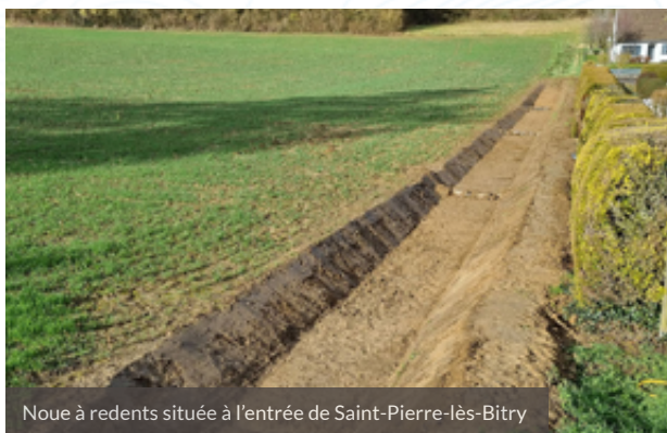
Noue de 1 000 m 2 avec 7 redents sur le plateau de la ferme du Gamet à Bitry
