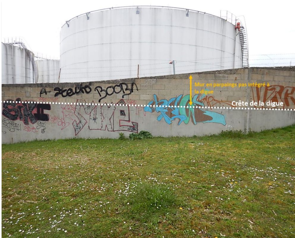
Figure 5-10 : Photo du tronçon 4 du système d'endiguement de Clairoix (Source : hydratec)
