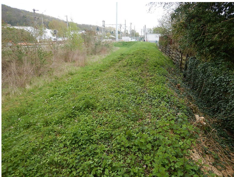
Figure 5-15 : Photo du tronçon 5 du système d'endiguement de Clairoux (Source : hydratec)
