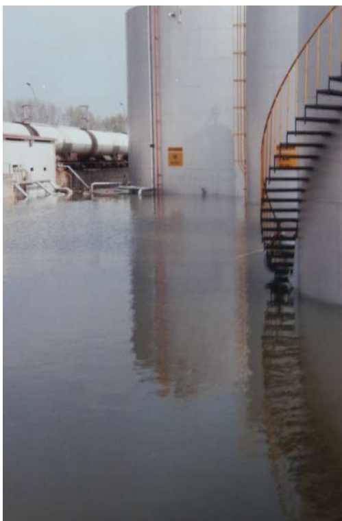
Figure 6-2 : Photo de l'inondation du site DMS lors de la crue de décembre 1993 (Source : DMS)
