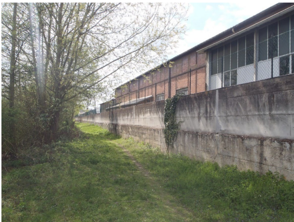
Figure 5-3: Photo du mur de protection au droit de PKM (coté Oise), tronçon 1 du système d'endiguement de Clairoix (Source : hydratec)
