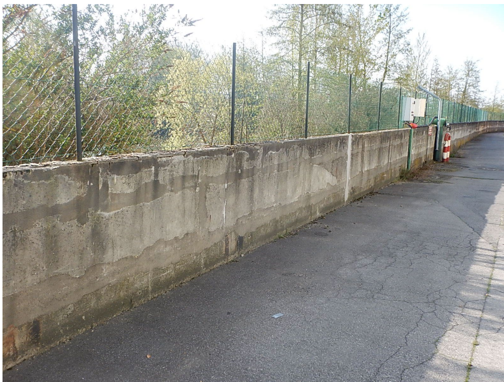
Figure 5-2: Photo d'un détail du mur de protection au droit de PKM (coté usine), tronçon 1 du système d'endiguement de Clairoix (Source : hydratec)
