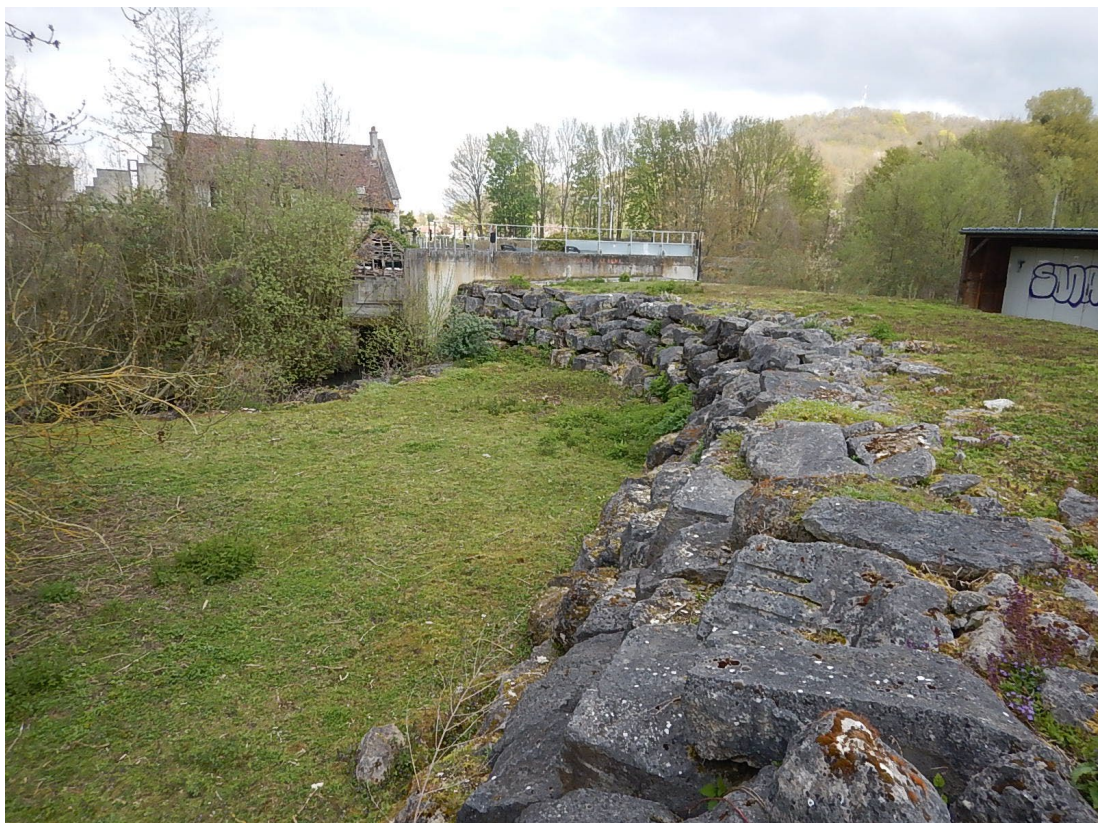
Figure 5-8 : Photo du tronçon 3 du système de Clairoux, partie en enrochement (Source : hydratec)
