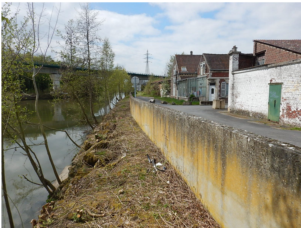
Figure 5-12 : Photo de la murette de protection du hameau du petit Breuil, tronçon 4 du système de protection de Clairoix (Source : hydratec)
