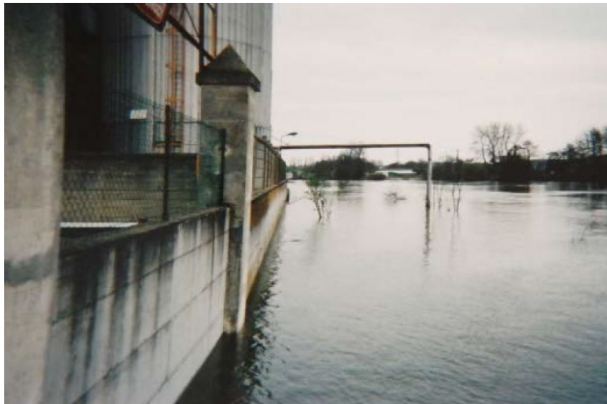
Figure 6-1 : Photo de l'inondation du chemin de halage devant l'entreprise PKM lors de la crue de mars 2001 (Source : PKM)
