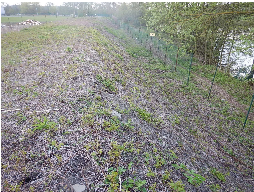
Figure 5-5 : Photo du tronçon 2 du système d'endiguement de Clairoix (Source : hydratec)
