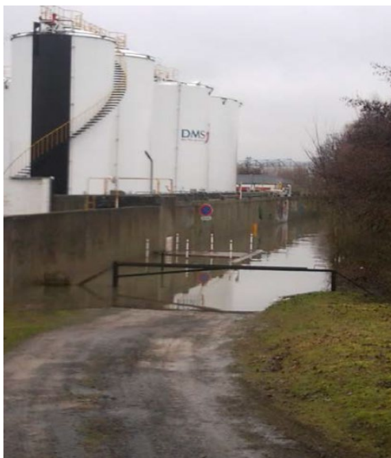
Figure 6-3 : Photo de l'inondation du chemin de halage devant l'entreprise DMS lors de la crue de janvier 2011 (Source : DMS)
